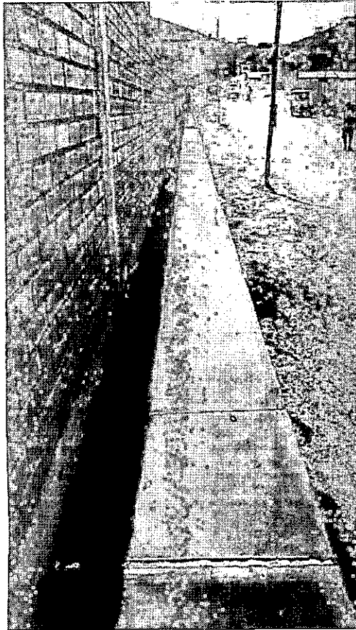
VISTA DE VEREDAS ZONA ESTE DE CERCO
